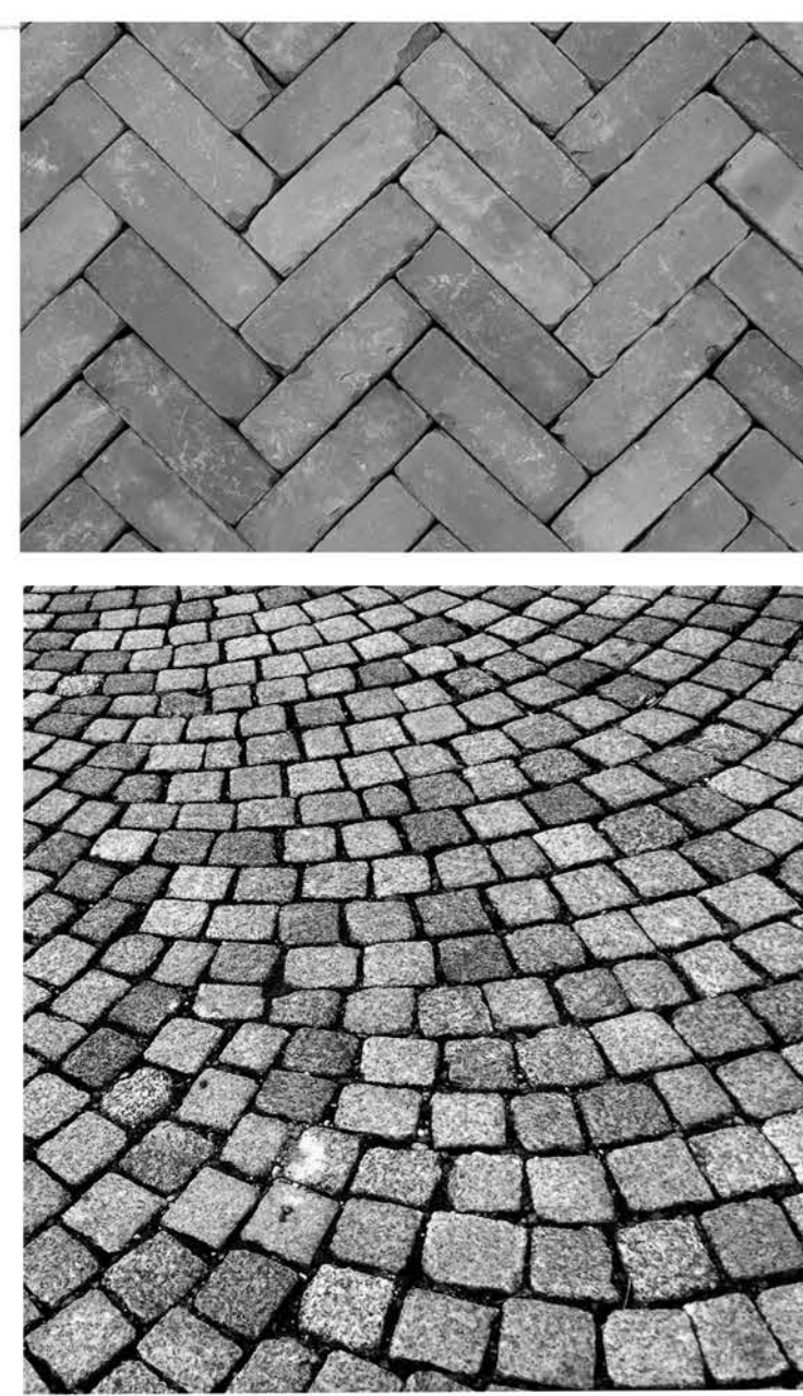
Grauwackepflaster bleibt erhalten, „Rahmen“ mit Klinkerpfaster im Fischgrätverband
